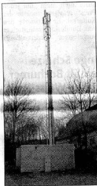
Der 20 Meter hohe Sendemast im Schulzentrum bereitet den Bürgern Sorgen. Foto: ff
