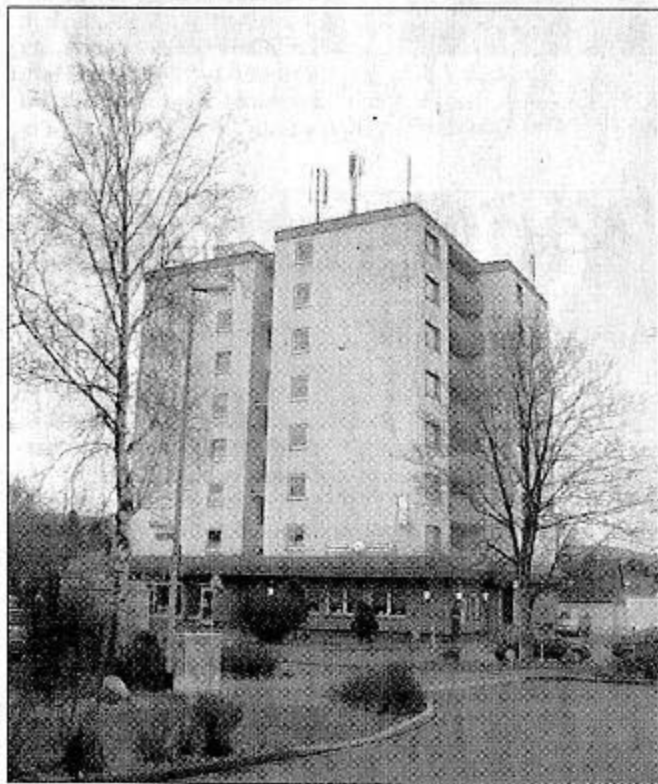
Auf dem Hochhaus im Attendorner Schwalbenohl stehen mehrere Mobilfunksender. Foto: anja
