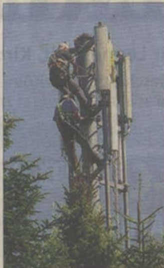
Der Sendemast im Schulzentrum wurde jetzt durch UMTS-Technik aufgerüstet.
